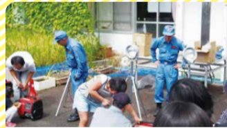
西前小学校 投光器訓練 避難所の明かり用に、発電機を始動させて投光器をつなげる訓練を行いました。
